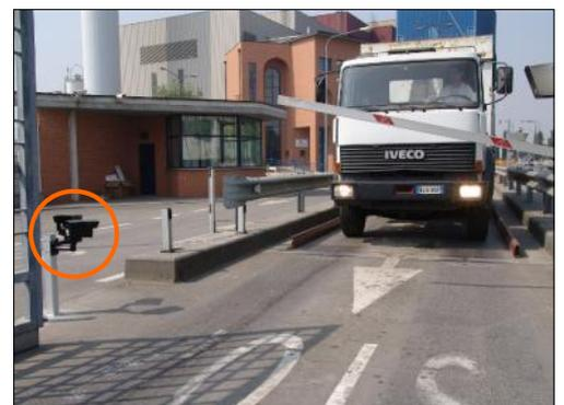
*Lettura della targa dell'automezzo, riconoscimento e apertura della sbarra di accesso*
