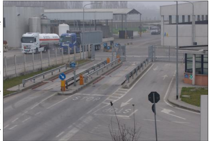
Varchi d'ingresso all'impianto
