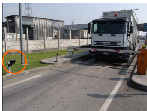
Lettura della targa dell'automezzo, riconoscimento e apertura della sbarra di accesso
