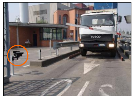
Lettura della targa dell'automezzo, riconoscimento e apertura della sbarra di accesso
