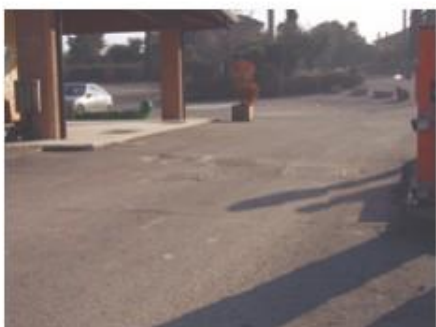
Point d'accès 2 voies
